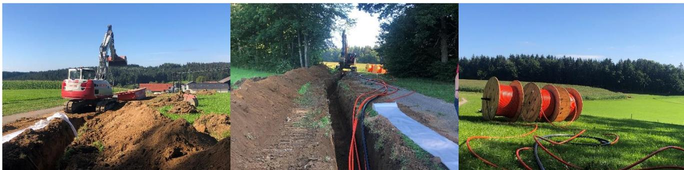
Von der Fiber Service Oö. werden in der Wasserleitungskünette auch gleich entsprechende Leerverrohrungen für das Glasfaser mitverlegt. Das Förderansuchen für den flächendeckenden Glasfaserausbau in St. Aegidi wurde mit Ende 2019 beim Bundesministerium für Verkehr, Innovation und Technologie (BMVIT) eingebracht. Die Entscheidung wird im Frühjahr 2021 erwartet.
